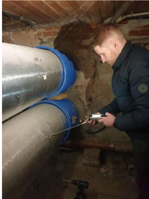
Bilde 4-1: Luftmengdemåling i hovedkanal i kjeller med hetetrådsanemometer – Foto: Christoffer Hermansen
