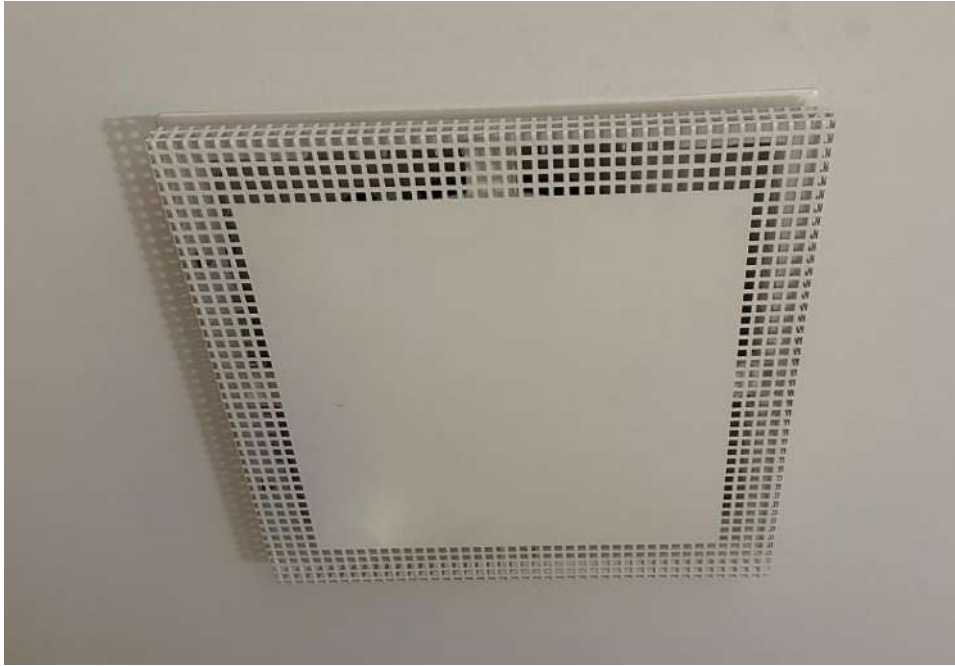
Bilde 3-3: Swegon PELICAN CS - Takmontert tilluftsventil – Foto: Stian Brekke
